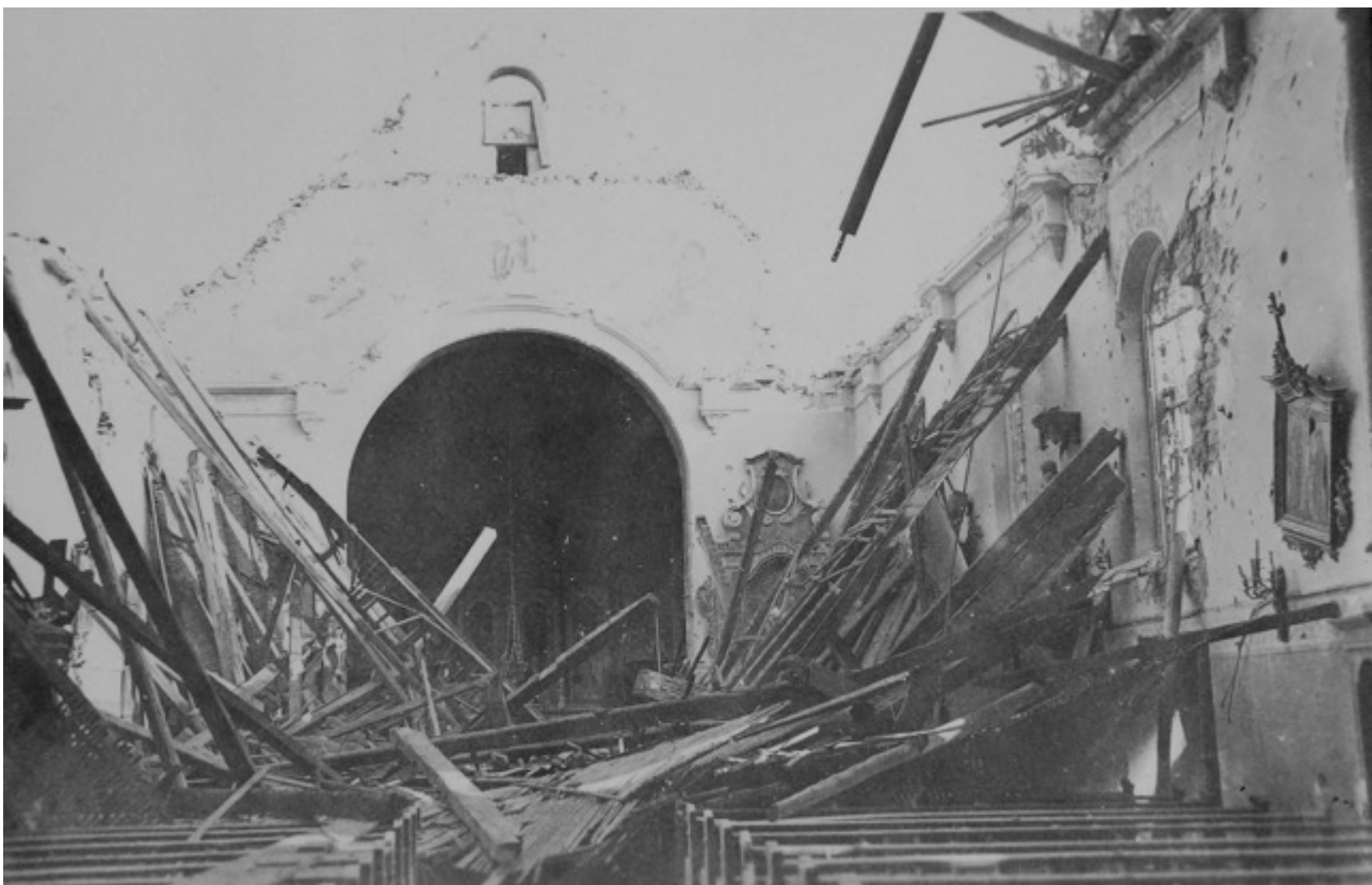
L'intérieur de l'église sinistrée de Grussenheim au printemps 1945. Les autels latéraux du 17 e siècle ont été très endommagés, alors que le retable du 18 e siècle dans le chœur a été miraculeusement préservé. (coll. Archives de la commune de Grussenheim)
